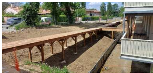
Assemblage panneaux platelage en atelier avec visserie inox A2 ou A4 en milieu marin
