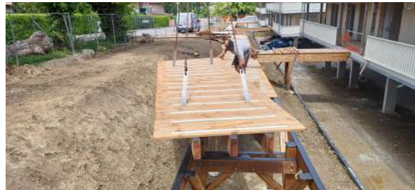
Assemblage panneaux platelage en atelier avec visserie inox A2 ou A4 en milieu marin
