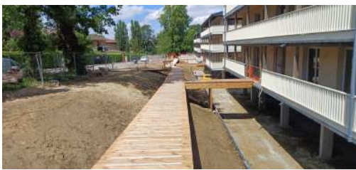
Pose des pannes porteuses périphériques avec bandes d'étanchéité
