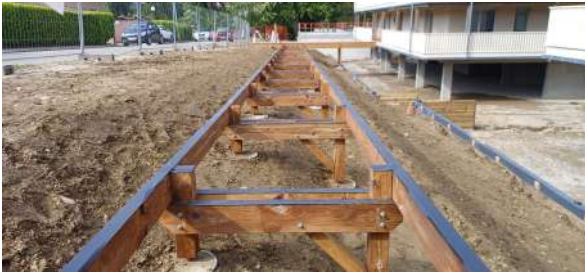
Pose des pannes porteuses périphériques avec bandes d'étanchéité
