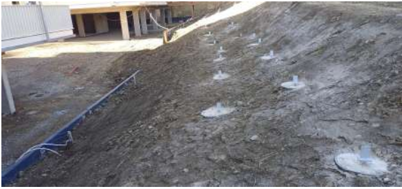
Implantation sur platines galvanisées
