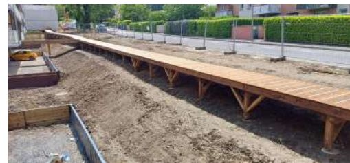
Assemblage panneaux platelage en atelier avec visserie inox A2 ou A4 en milieu marin
